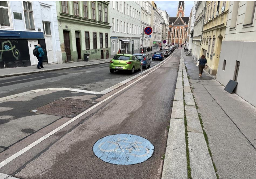
Wien – breiter Radweg, KFZ-Spur auf eine Richtung reduziert – parallel gegenläufig
